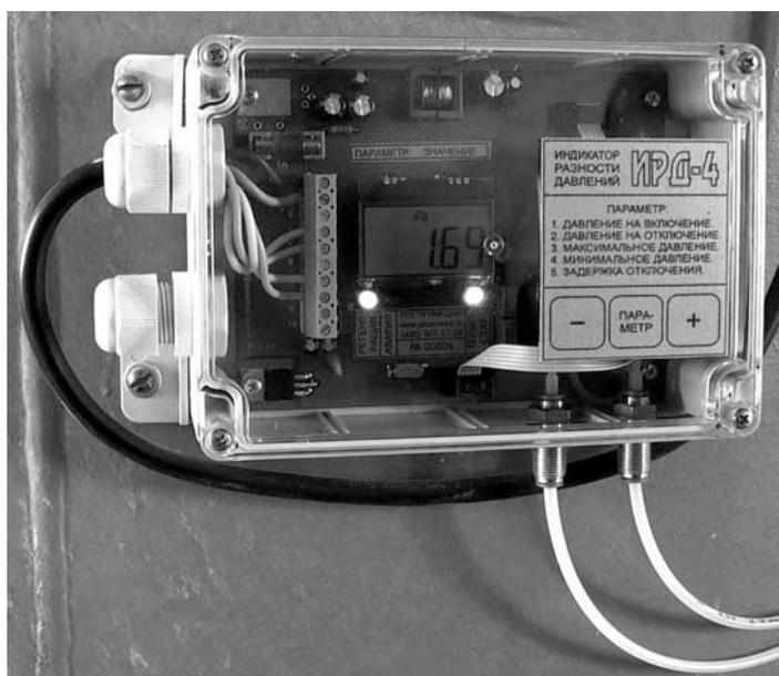
Прибор работает совместно с любыми блоками продувки, которые через электропневмоклапаны или пневмораспределители подают сжатый воздух внутрь фильтровальных элементов. В комплект поставки входят соединительные штуцера для установки на фильтр, а также отрезок пневмотрубки длиной 10 метров.
